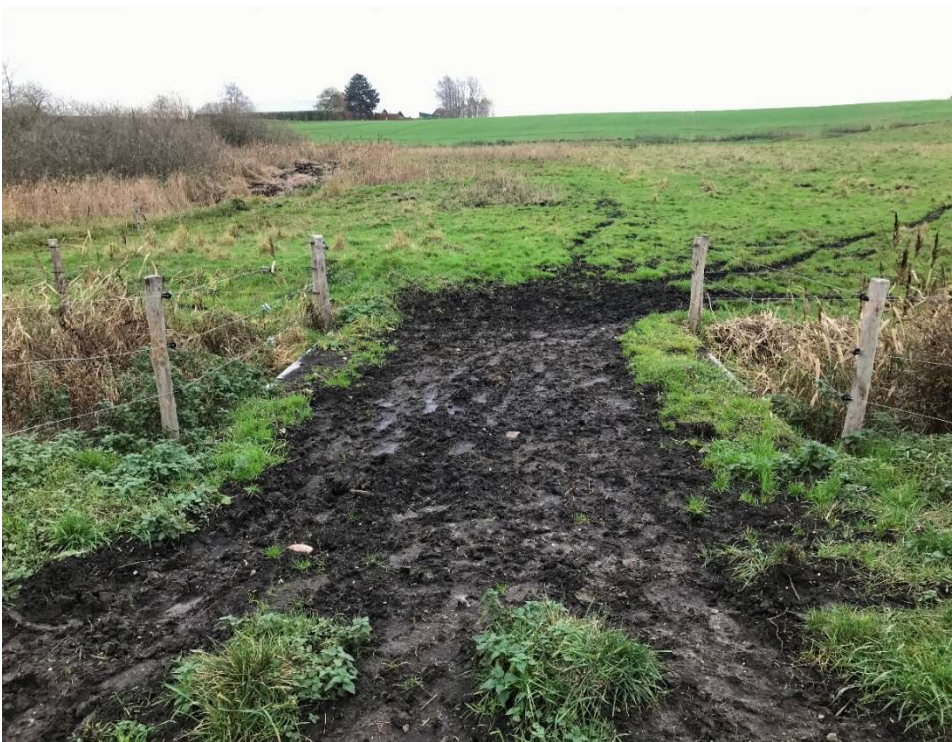
Figur 7 Kvægovergang, 4 m bred. Udført i ubehandlet eg. Der er lagt jord på broen for at få kvæget over. Der er lille kant på for at sikre mod jord i vandløbet. Senere kan jorden muligvis fjernes. Der er dyrehegn på hver side af broen.
